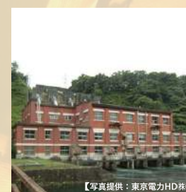
猪苗代 第二発電所
